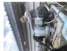
4. ตรวจสอบการทำงานของเกียร์มอเตอร์
